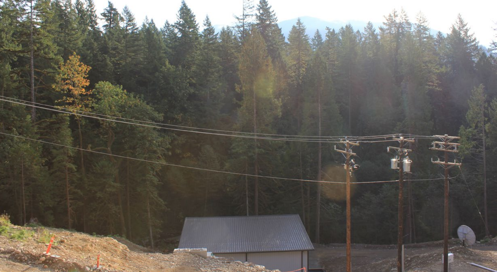
Sakwi Creek Powerhouse
